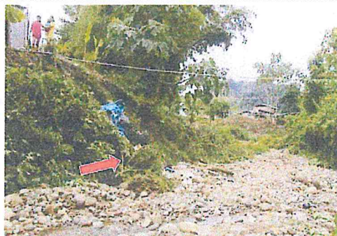
FOTO 02: Vista de afectación a vivienda en la margen izquierda del río Umpikiri. El material del talud izquierdo es inestable, altamente erosionable.
