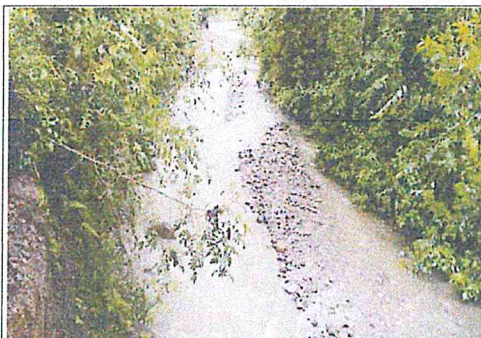
FOTO 01: Vista panorámica del río Umpikiri, se observa el estado colmatado en la parte central del cauce.
